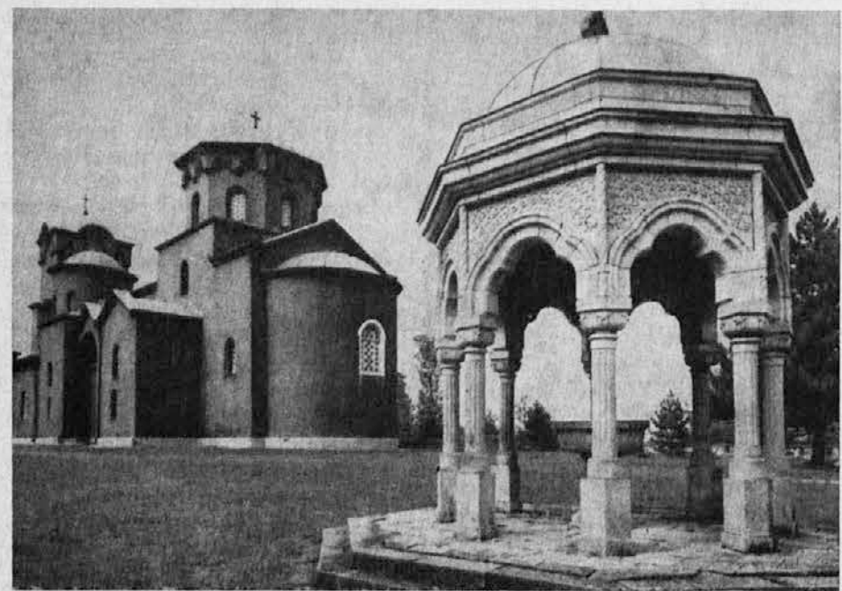
Samostan Žiča, prvi sedež patriarha srbske Cerkve. Zgradil ga je kralj Stefan Prvovenčan, brat sv. Save, ki je bil prvi nadškof srbske, od Bizanca in Rima neodvisne Cerkve. Kasneje se je patriaršija preselila v Peč blizu albanskih gora, pred Turki pa se spet premestila daleč na sever, preko Save v Sremske Karlovce. Danes je patriarhov sedež v Beogradu.
