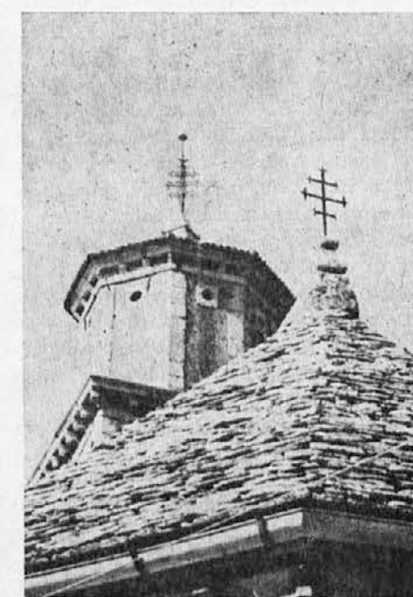
Obnovljeni križ na vrhu zgoniškega cerkvenega stolpa
